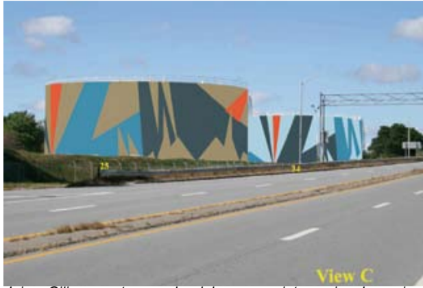
Jaime Gili, proyecto ganador del concurso internacional para intervenir 16 tanques de gasolina venezolana en Portland, Maine, 2008.
